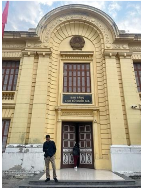
外観・そそくさと施錠する係員
