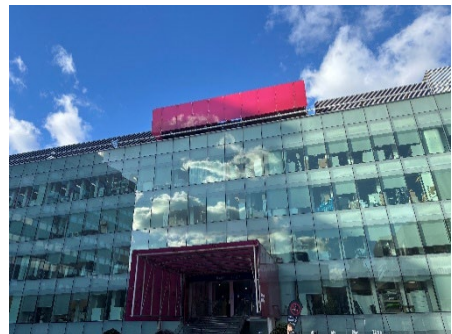
ガラス窓の様子
