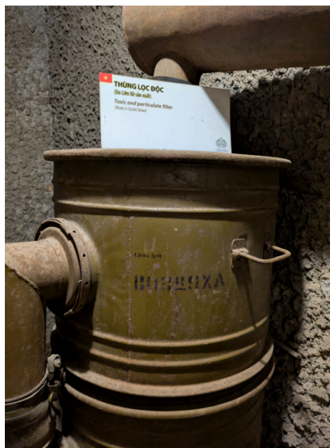
フィルター設備
