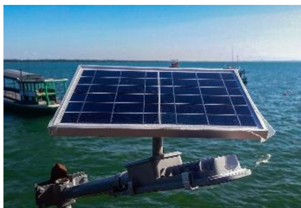
図 2.3.5. 漁船の太陽光発電用照明灯
