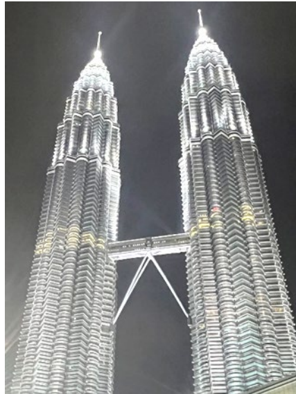
図 4.1.1 ペトロナスツインタワー
