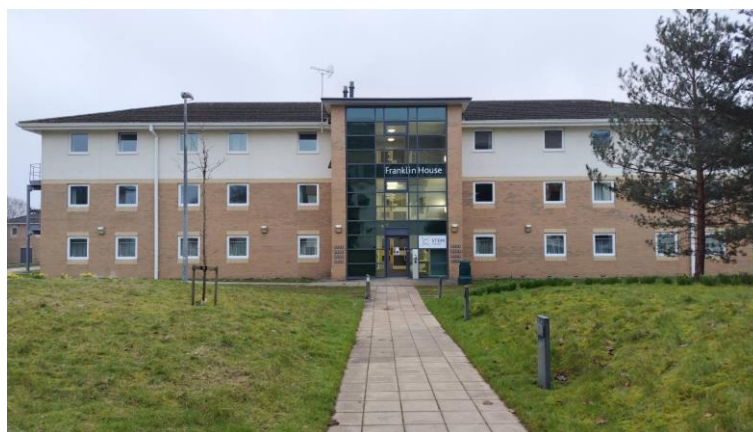
図 7.4.8 Franklin House 外観
