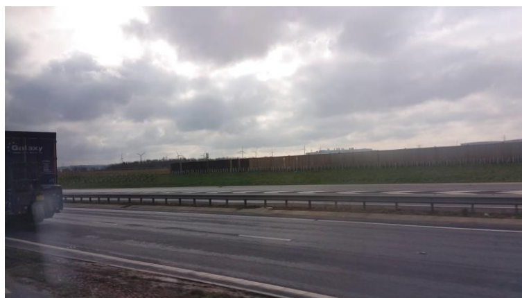
図 7.5.1 サンダーランド工場の風力発電機
