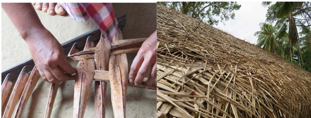
図 4.4.4.10 屋根を作る様子
