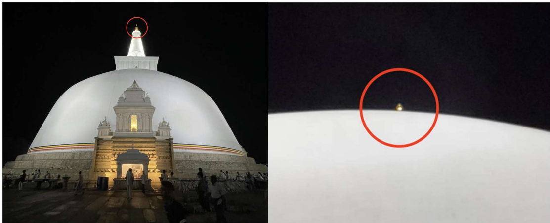
図 4.2.4.6 ルワンウェリ・サーヤ大塔(全体)
