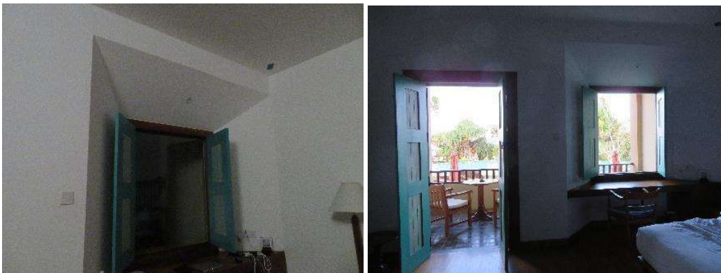
図 5.4.10 壁と窓が斜めに接続されている
