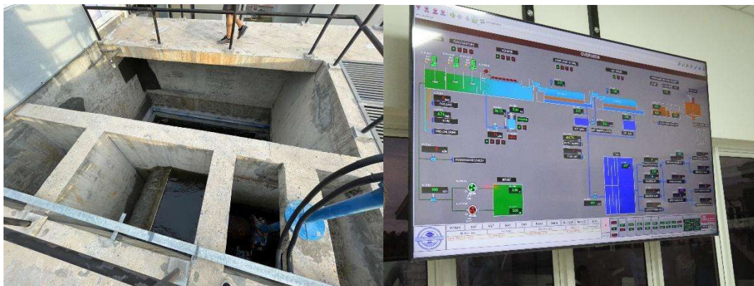
図 4.2.2.1 上水処理の過程のフィルターの 1 つ
