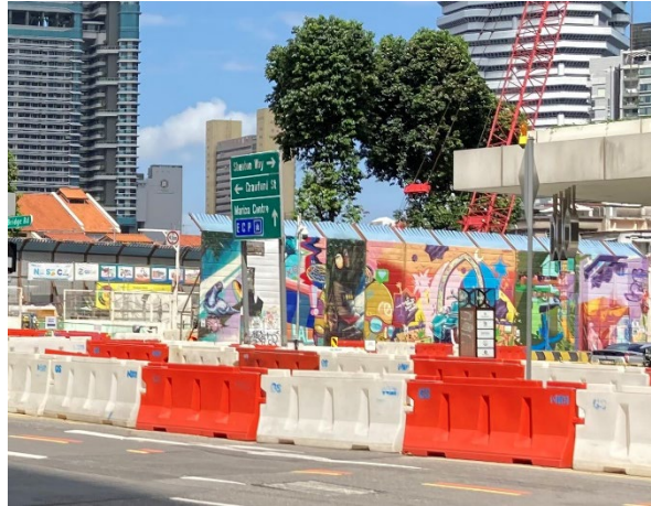
図 5-5.2 工事現場のアート
