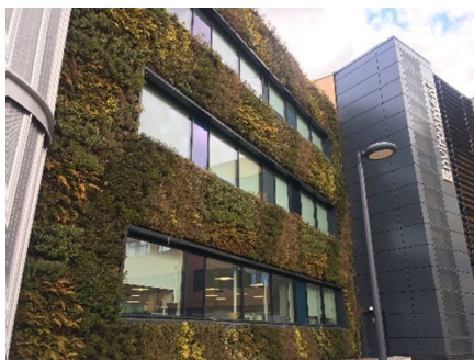
図 15 環境学科研究棟の壁
