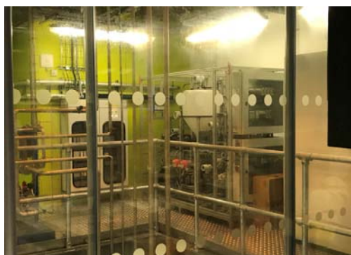
↑装置右側。制御に関わる装置が多い。
