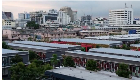
整備が終わった区画と未整備の区画の比較(手前が整備が終わった区画)
