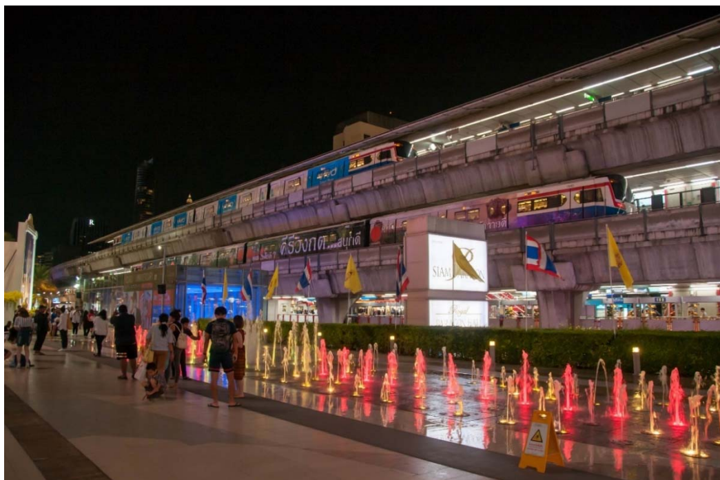
BTS サイアム駅(駅が2層構造になっている)
