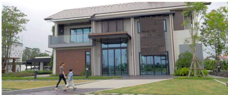
スマートハウス外観
