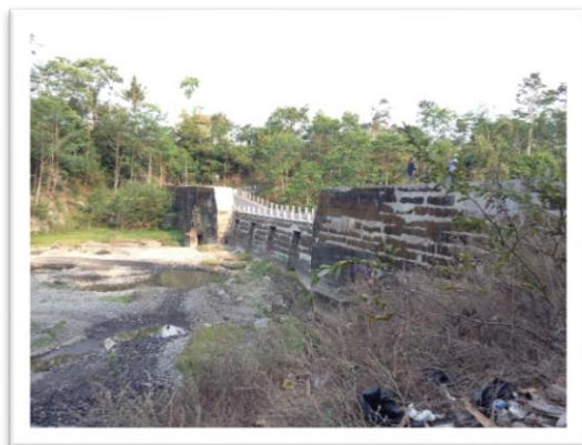
写真 2 最初に完成した砂防ダム
