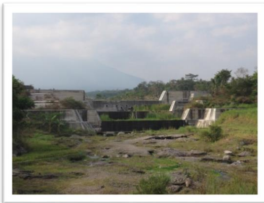
写真 1 砂防ダム全景
