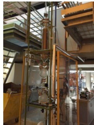
大型の蒸留装置
