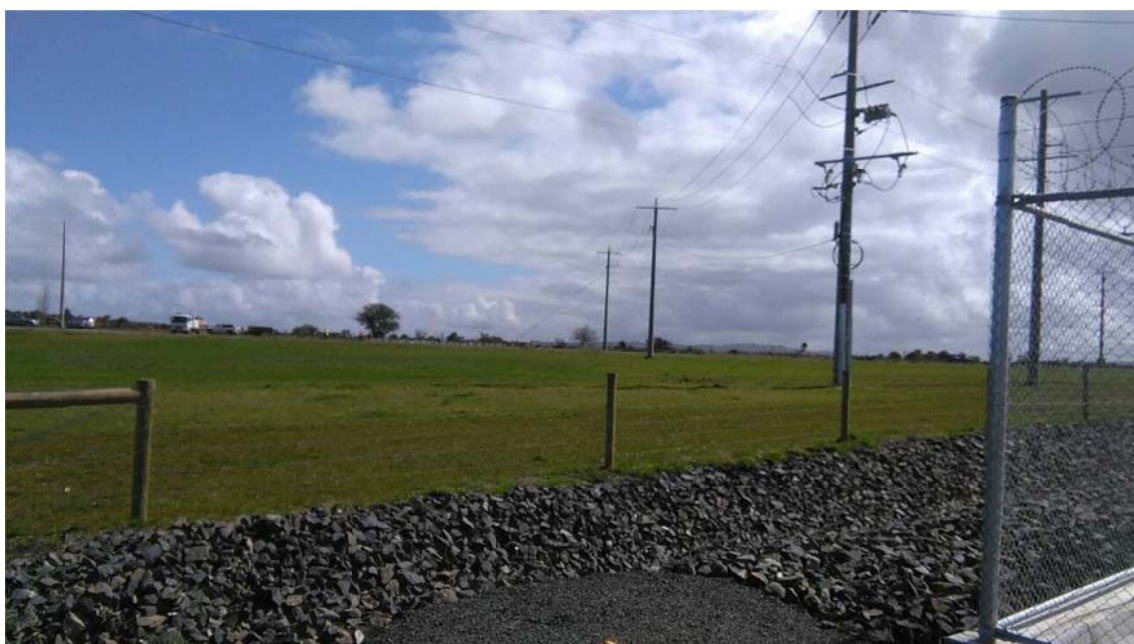
(写真 2 : Wind Farm につながる電線)
