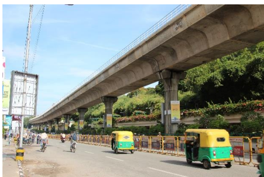
メトロの線路は、道路の上の高架に建設されている
