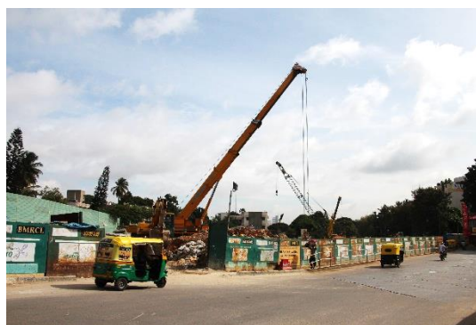
地下の駅や線路の工事が進む、ティプー・スルターン宮殿付近の現場
