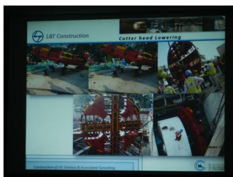
スライドで工事の説明を受けた
