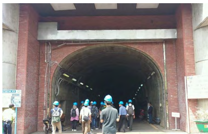
図 24 水力発電所入り口
